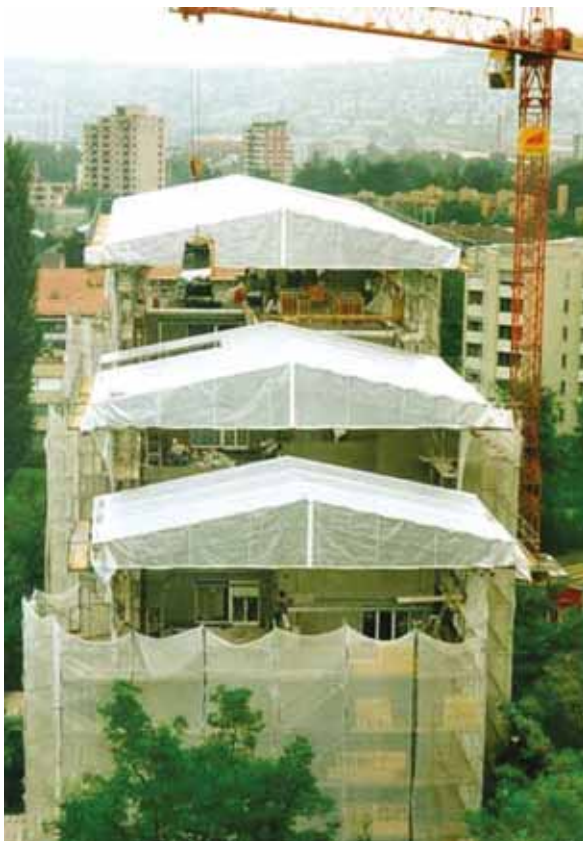
Abb. 6: Beispiel des Witterungsschutzes mit Notdach und Planen, Quelle: Schneider Gerüstbau AG
