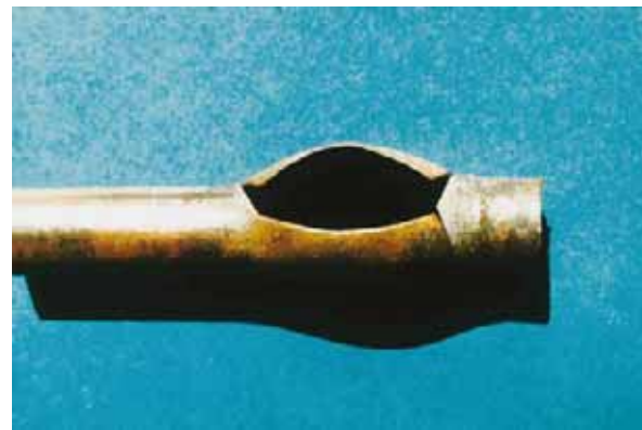
Abb. 9: Leitungswasserschäden durch Frost, Quelle: Schadenprisma 4/1997, Heiko Hupe
