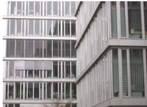
Abb. 11: Beispiel vollflächig verglaster Fassade, Quelle: M. Wang
