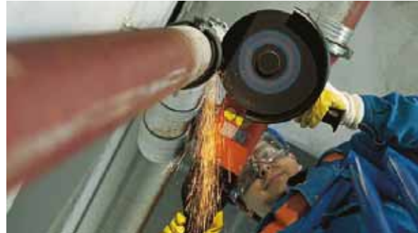
Abb. 13: Funkenbildung bei der Trennschneidarbeit, Quelle: http://www.infopool-bau.de
