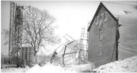
Abb. 8: Gerüste nach einem Wintersturm, Quelle: VdS 2389
